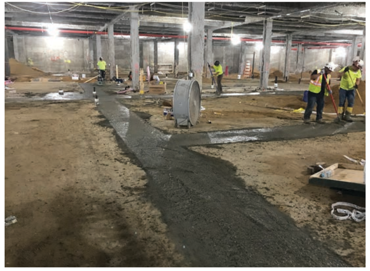
A concrete footing pour at 1111 Franklin Avenue.
